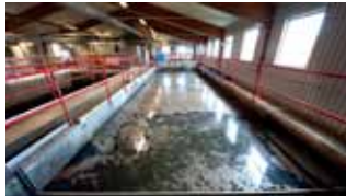
Bygga nytt eller inte? Åsikterna i reningsverksfrågan går isär. FOTO: JENS ALVIN
